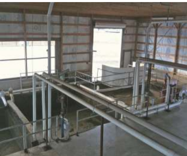
Seadme sisend spetsiaalse peenestuspumbaga
